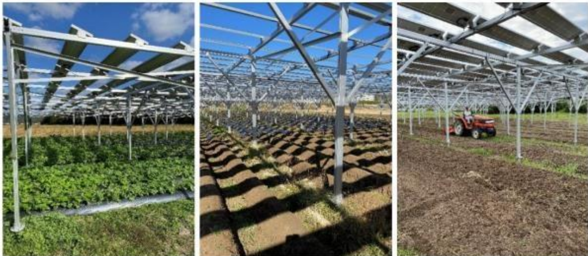
図 4-7 ソーラーシェアリングの設置風景（国内事例）
