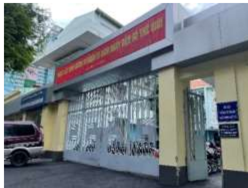
ホーチミン市天然資源・環境局事務所
