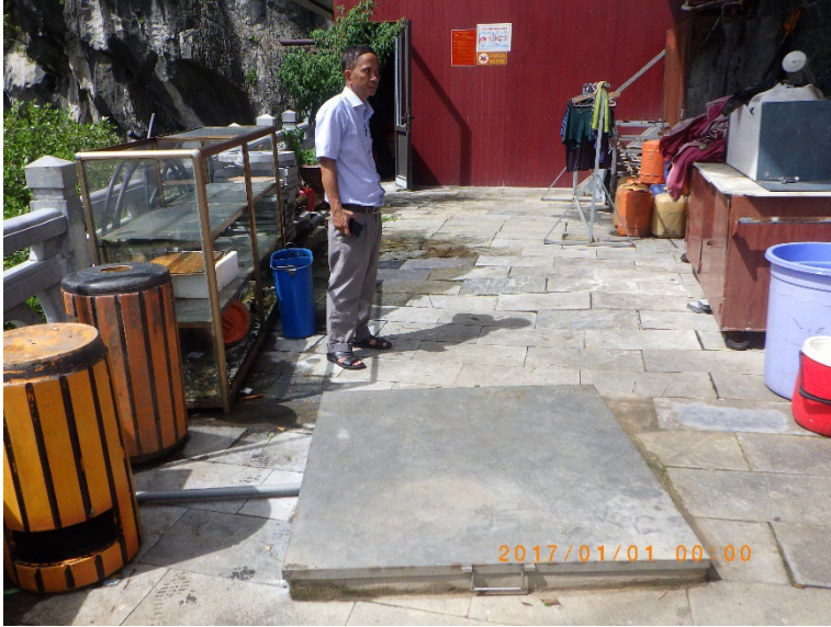
ダウゴー洞窟のスタッフ用 トイレの浄化槽導入予定地 点(1基)
