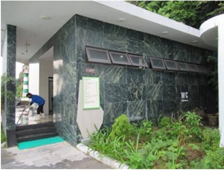
浄化槽を導入したトイレ
