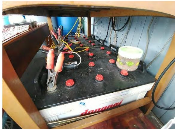
太陽光パネルで発電した電力を貯めるための鉛蓄電池（1ヵ所目の水上筏）
