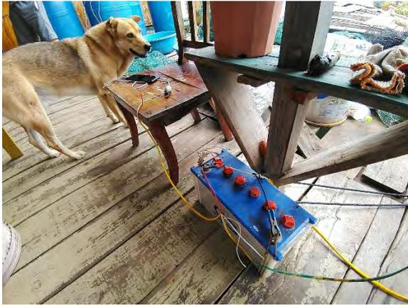
太陽光発電パネルで発電した電力を貯める鉛蓄電池（2カ所目の水上筏）
