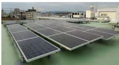
県有施設(西部子ども家庭センター)の屋根
