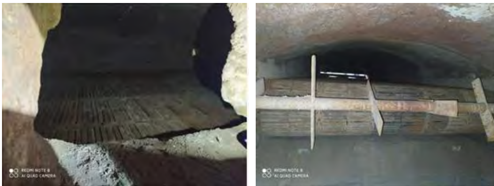
図 40 ストーカーの火格子（左）（燃料を右に移動）とストーカー燃焼灰排出口（右）
