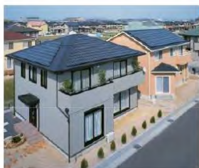
一般民家の屋根
