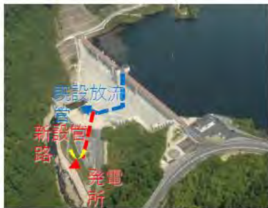
福富ダム(出力370kw, 発電電力量約2.6GWh/年)
