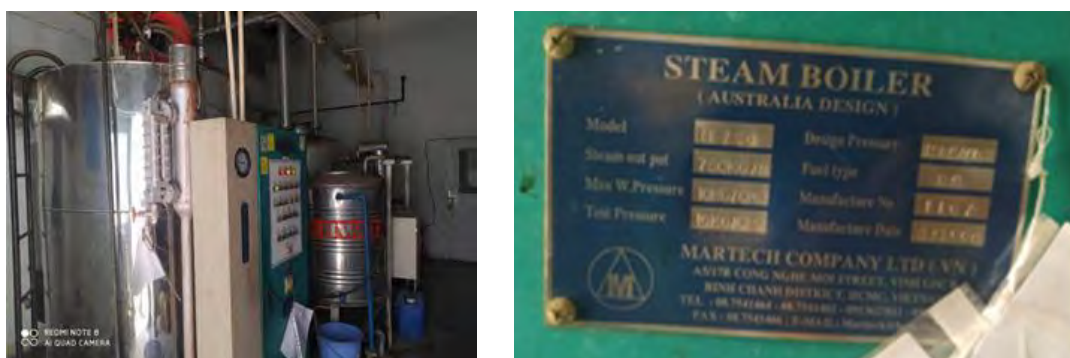
図 36 MTI 社で使用しているディーゼル油焚ボイラ
