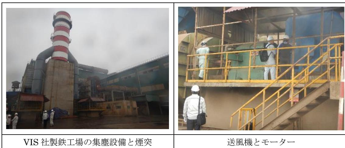
図 3.19 VIS 社製鉄工場集塵設備外観
