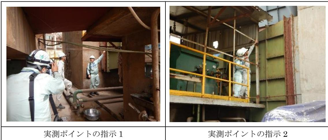
図 3.21 送風機風量・圧力実測ポイントの説明
