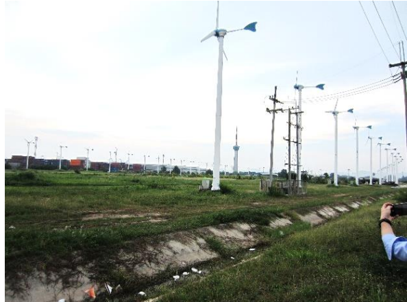
②風力発電施設と下部の空地
