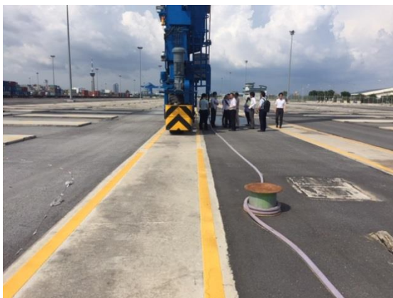
③地上を這うケーブルの様子
