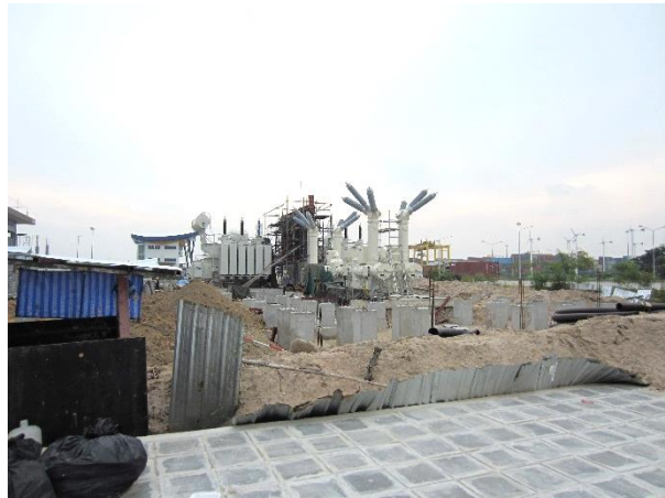
④新しい変電所の工事状況
