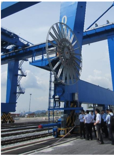
①RTG のケーブルリール部分
