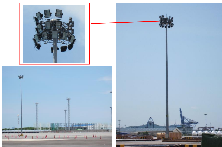
写真 8 多目的ターミナルにある照明柱および照明灯具
