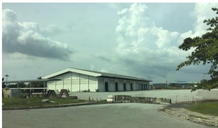
写真 5 PAT 所有の既存上屋建物（2018年5月撮影）
