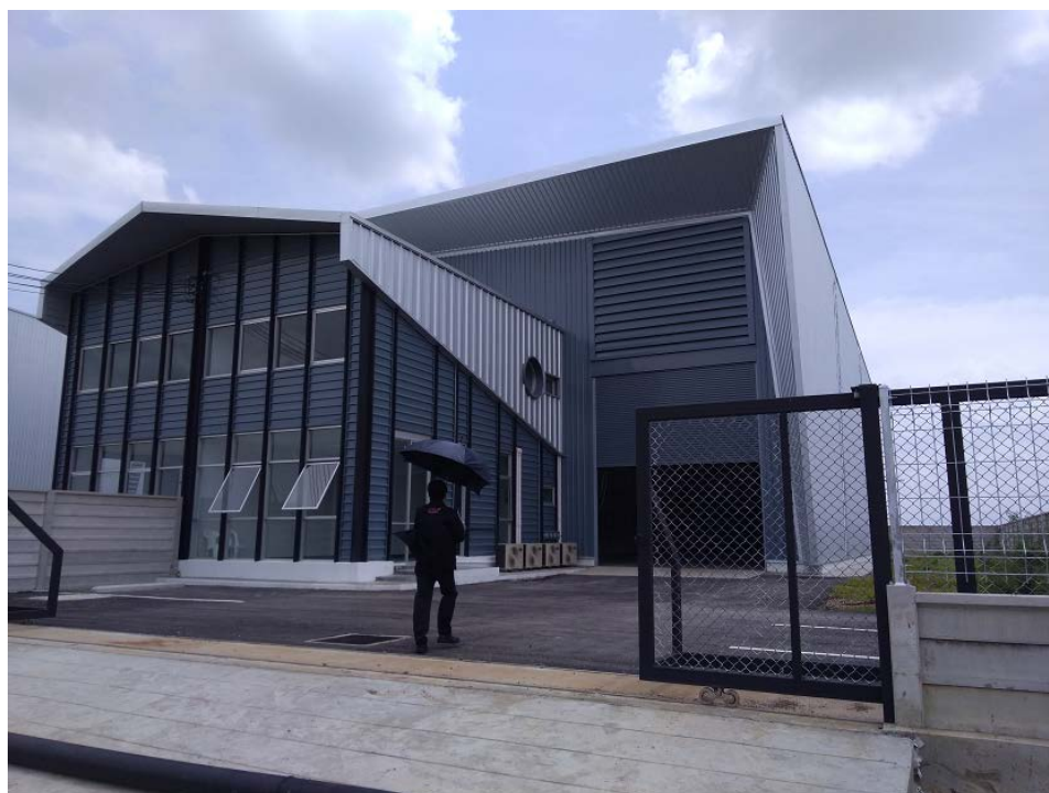
図 3-2-7 SA KAEO 工業団地に建設済のモデル工場
