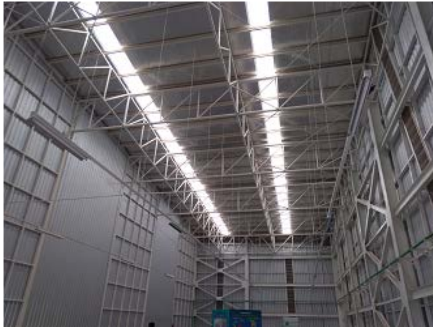
図 3-2-8 モデル工場内の明かり取りスリット
