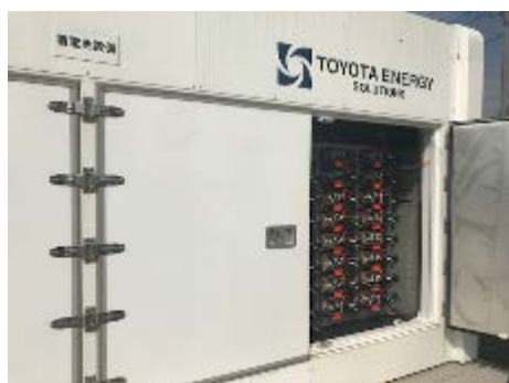
リユースバッテリーシステム
