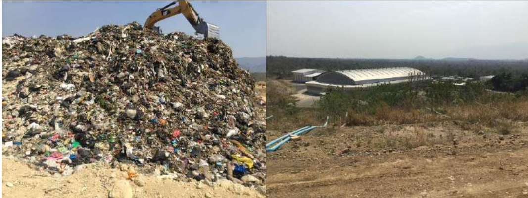
Hord 最終処分場(左)と LFG 回収施設(右)
