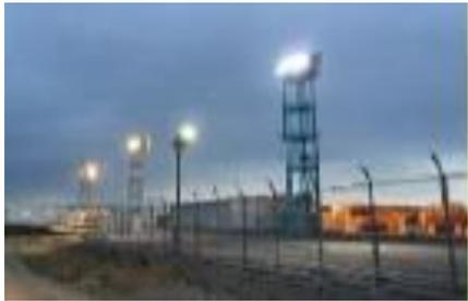
本プロジェクトでは、レムチャバン港自動車ターミナルにおけるヤード照明用に既存の水銀灯を左図に示す LED 照明器具と交換する。LED 照明器具の稼働時間とグリッド電力消費量をモニタリングする。LED 照明器具の稼働時間はセンサーにより自動計測するか、プロジェクトの事前または事後において一定期間の日稼働時間を調査してデフォルト値を設定する。
