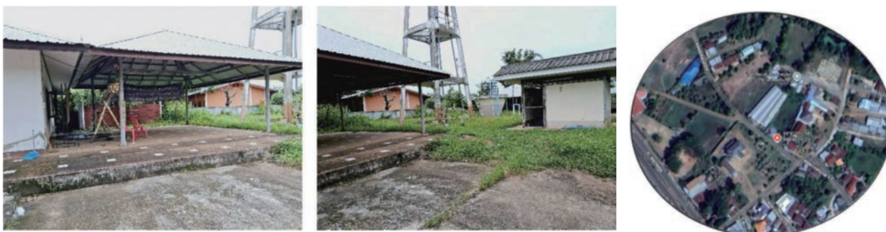
第 1 地区 水源区(井戸)
