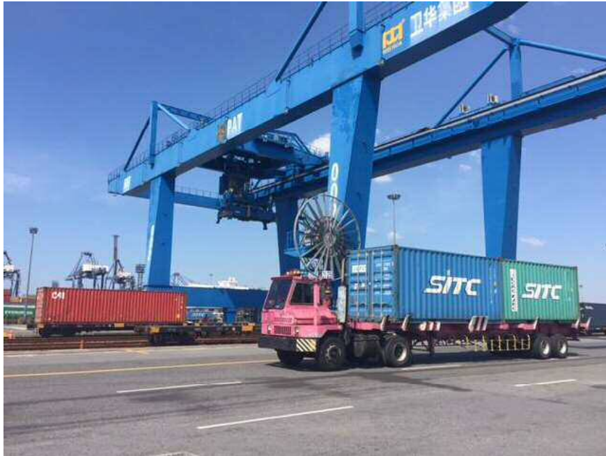
写真 9 鉄道ターミナル（SRTO）に設置された RMG
