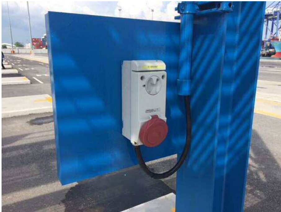
写真 12 内航船ターミナル (Coastal-A) のリーファープラグ
