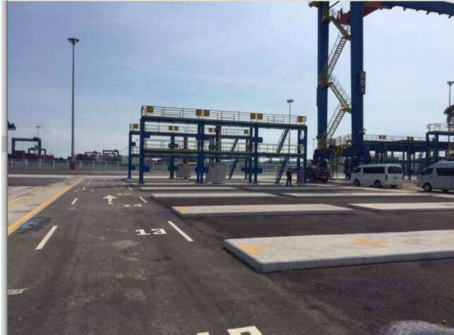
写真 11 内航船ターミナル (Coastal-A) のリーファーエリア
