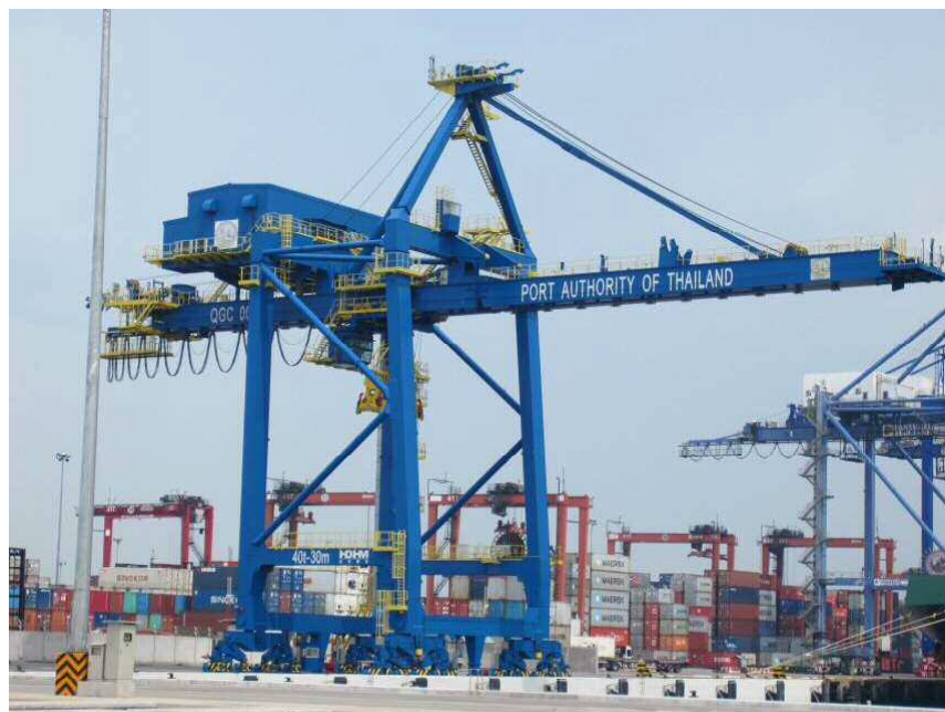
写真 2 内航船ターミナル (Coastal-A) に設置されたコンテナクレーン
