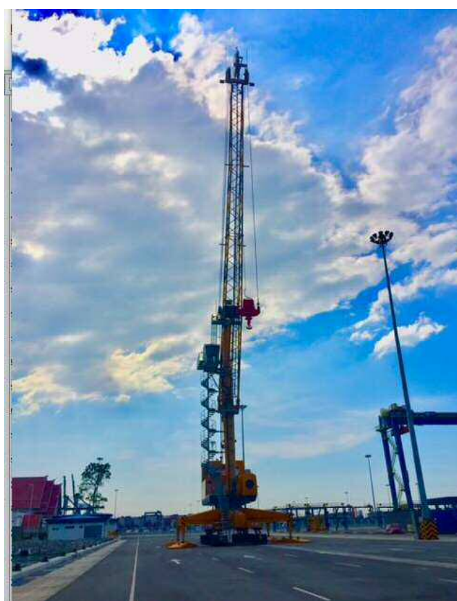
写真 3 内航船ターミナル (Coastal-A) に設置されたモバイルハーバークレーン
