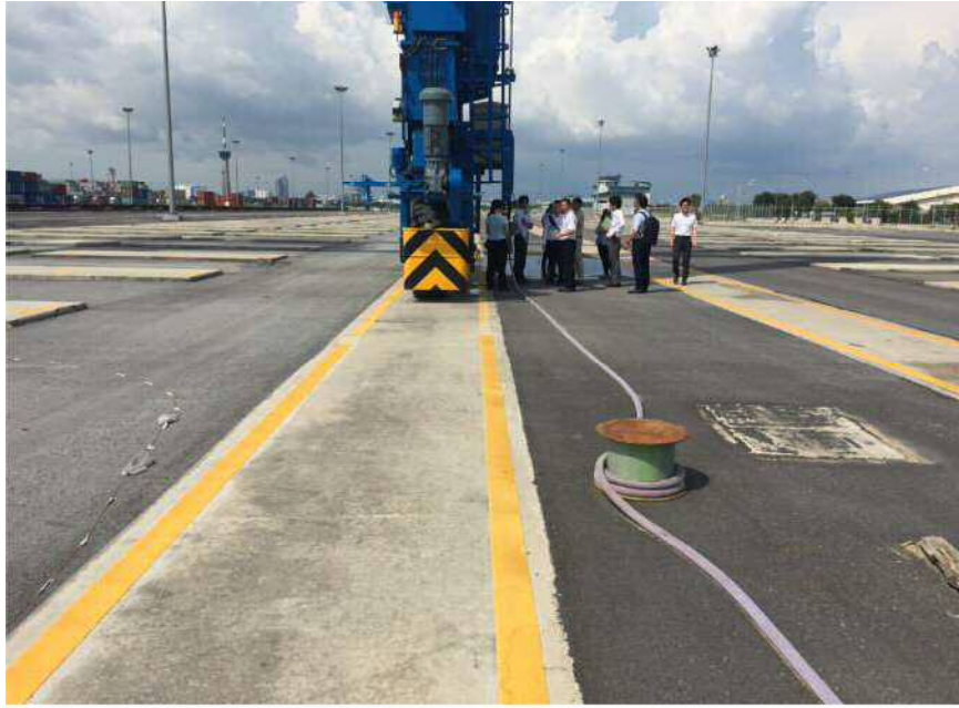
写真 13 ヤード舗装上に這った状態の RTG ケーブル
