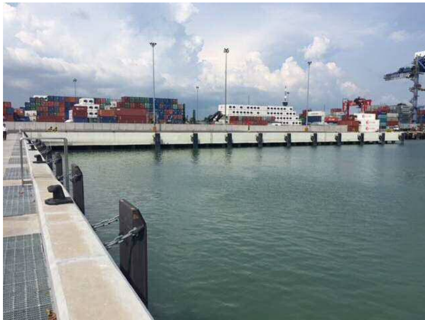
写真 5 内航船ターミナル (Coastal-A) の岸壁
