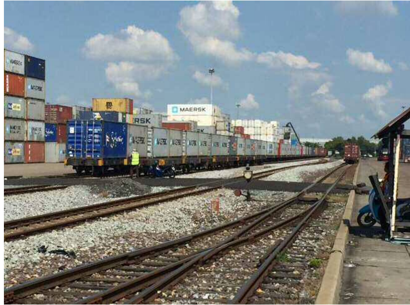
写真 14 ラッカバン ICD での荷役状況 (1)
