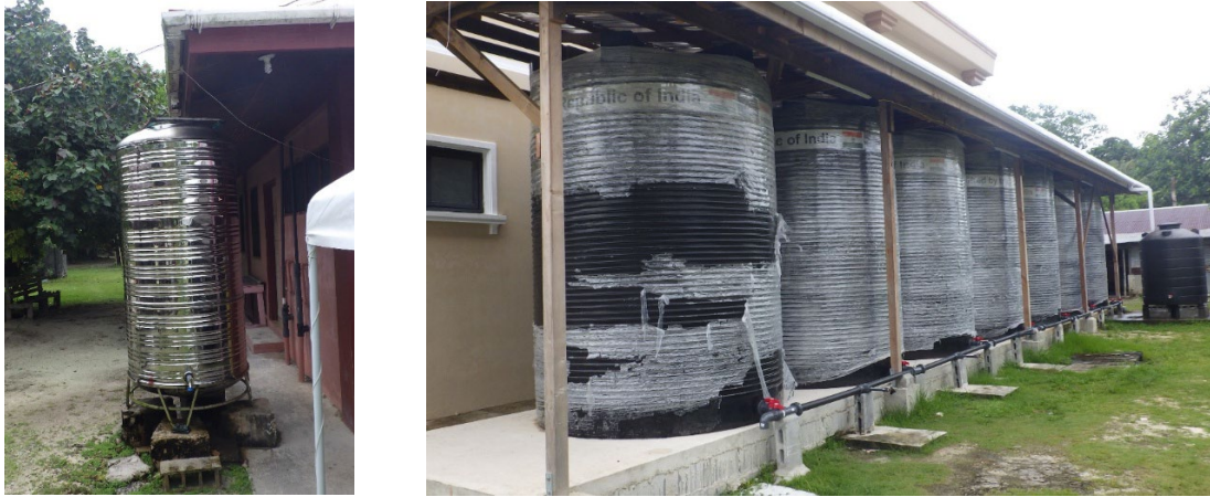
図 2.2-6 飲料水を取得するための雨水タンク (左：家庭用タンク 右：公共用巨大タンク（インドからの支援）)
