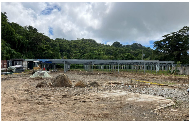
図 2.3-2 PPR 工事状況 (2025 年 9 月撮影)
