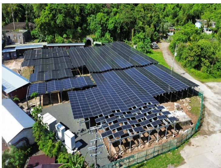
図 2.3-3 PPR 工事完了状況
