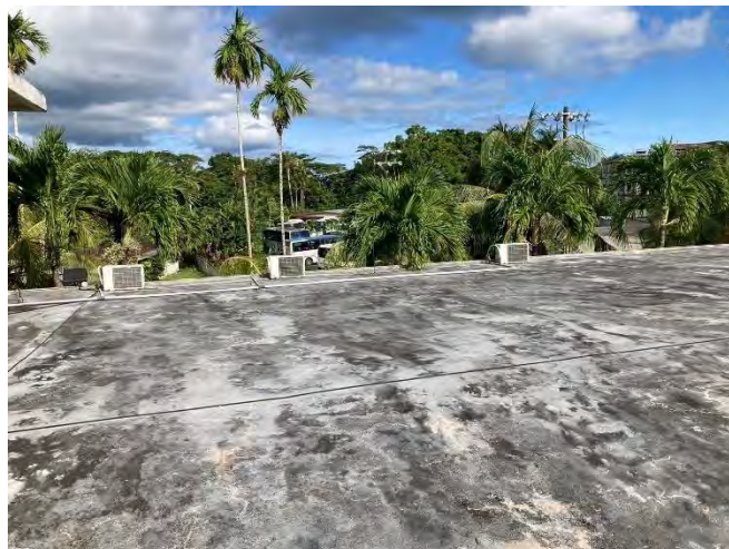
図 2-4 : コロール州庁舎の屋根写真
