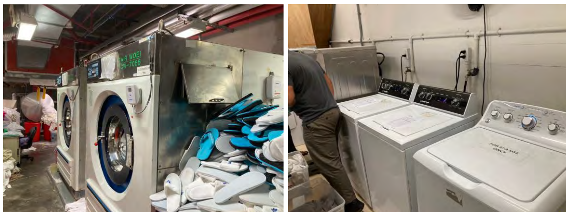
図 3-7 : リネンクリーニングの現場の様子 大規模ホテル(左)・中規模ホテル(右)
