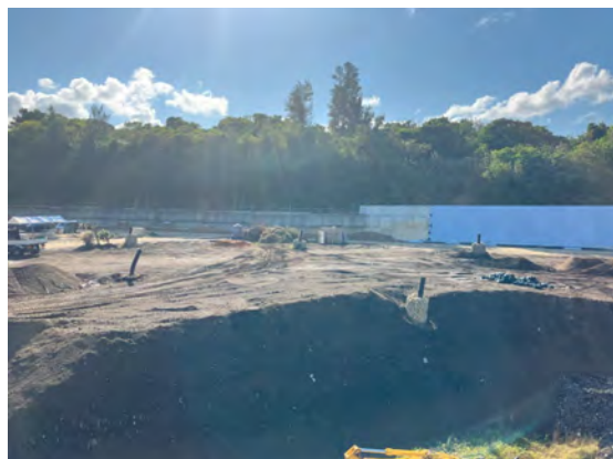
写真 4 最終処分場の様子
