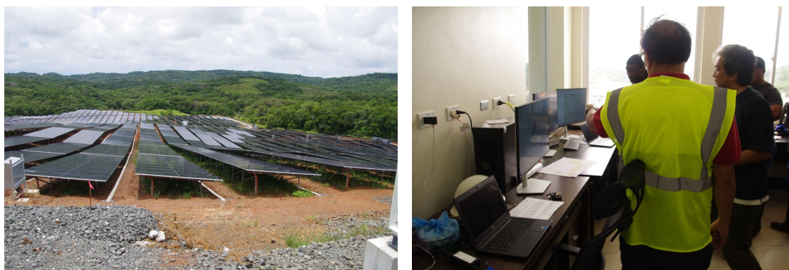
図 2-20 Solar pacific 社発電所と制御室
