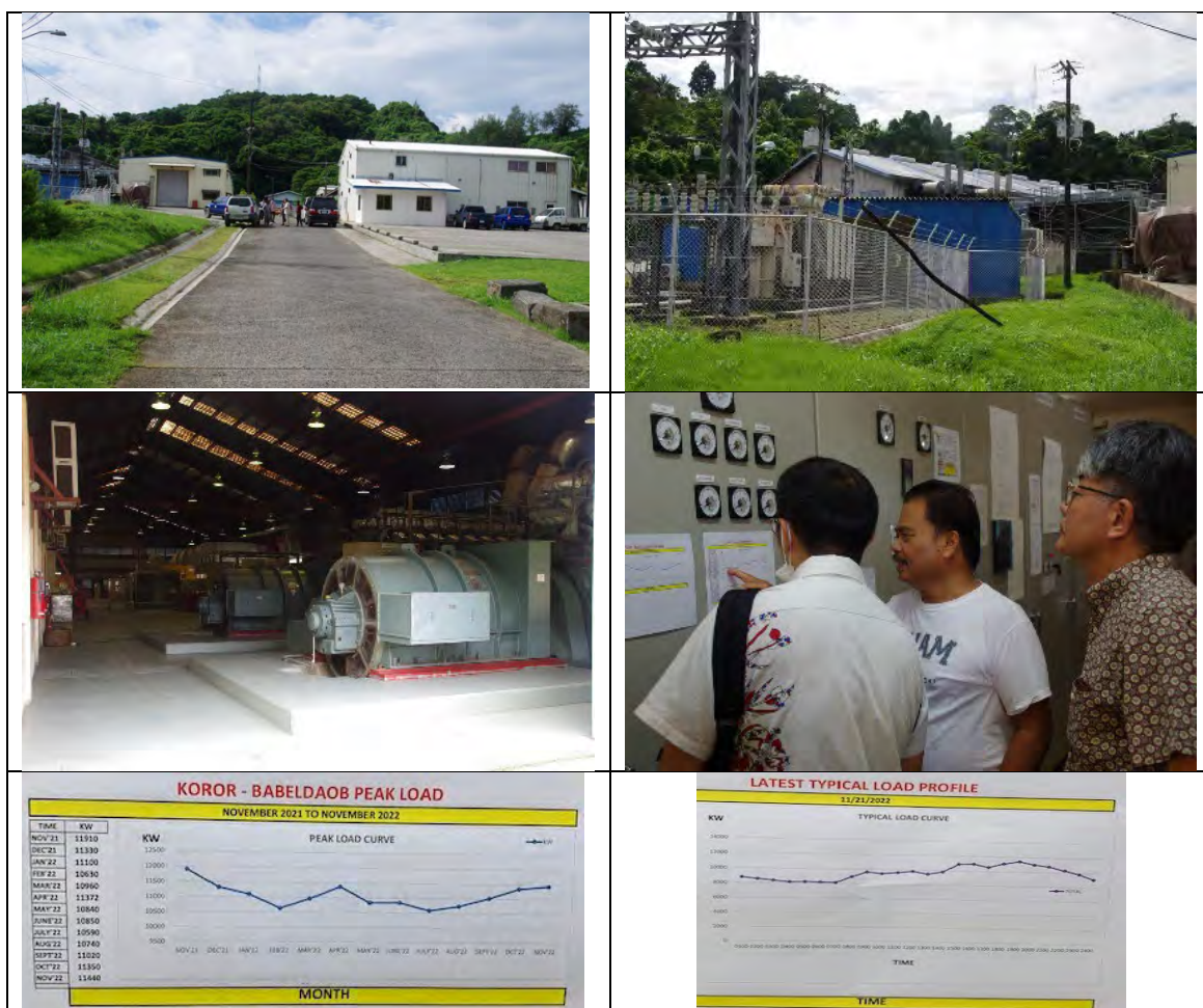
図 30 マラカル発電所視察の様子と受領した電力需給データ
