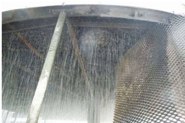
図 22 冷却塔内冷却水散布状況
