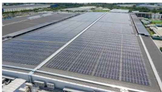
図 3-16 屋根置きソーラーパネル
