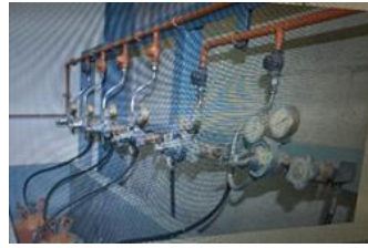
フロンの注入（インドネシアの事例）
