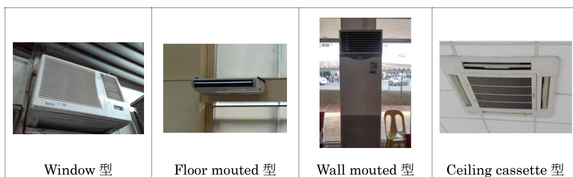
図 3-7 ケソン市市庁舎に導入されている空調機器の種類
