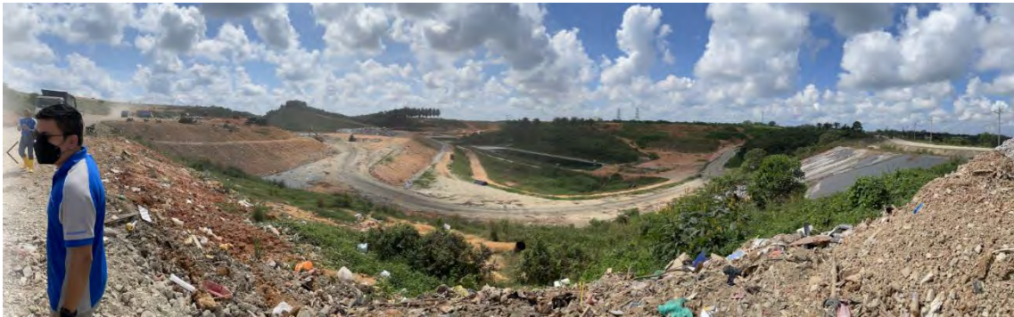
写真 4-9 視察時埋立場所の俯瞰写真 (写真左側：埋立場所、写真中央：一次集水池)
