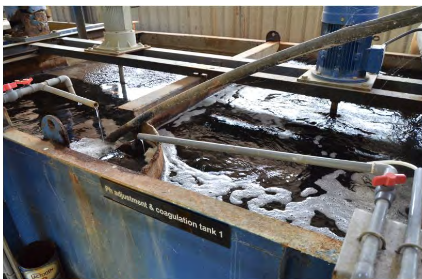
写真 4-15 (4) Chemical Treatment による重金属除去 (ラメラセパレーター)
