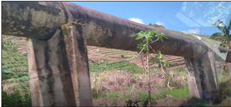
図 4-10 送水用のパイプライン
