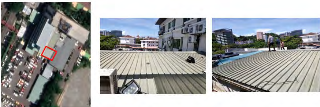
図 4-22 エリアBの屋根の様子
