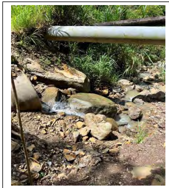
図 4-13 Mesilou 川取水口からの地上ペンストックの様子
