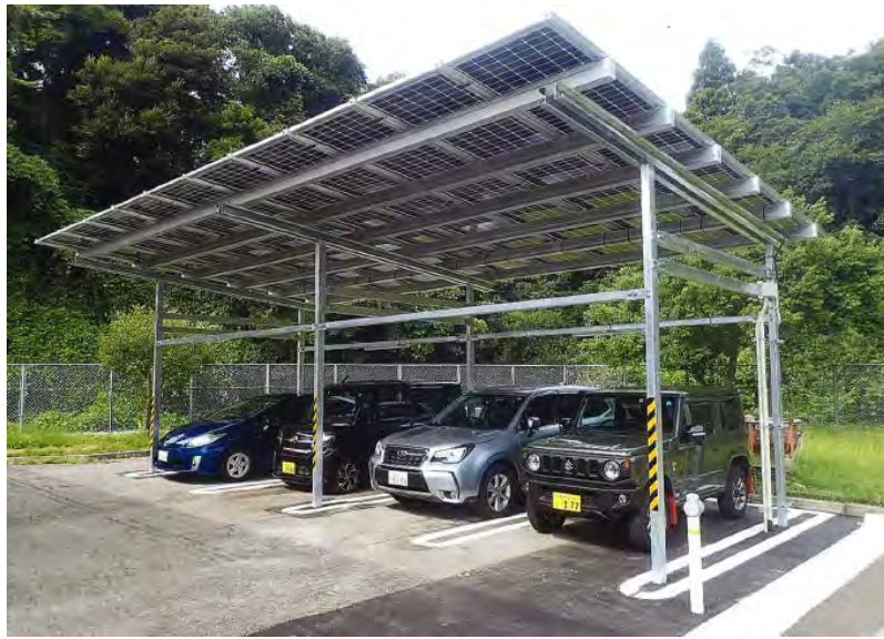
図 4-26 カーポート型太陽光発電システム
