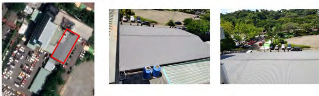
図 4-23 Cビル屋上の様子
