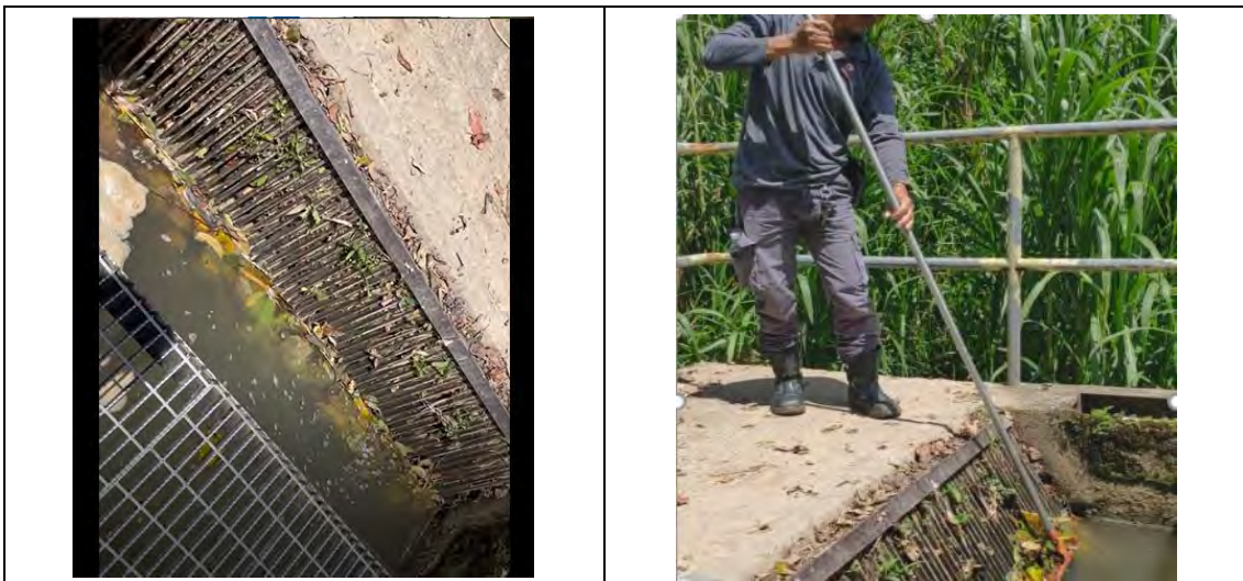
図 4-9 Liwagu 川送水口及びメンテナンスの様子
