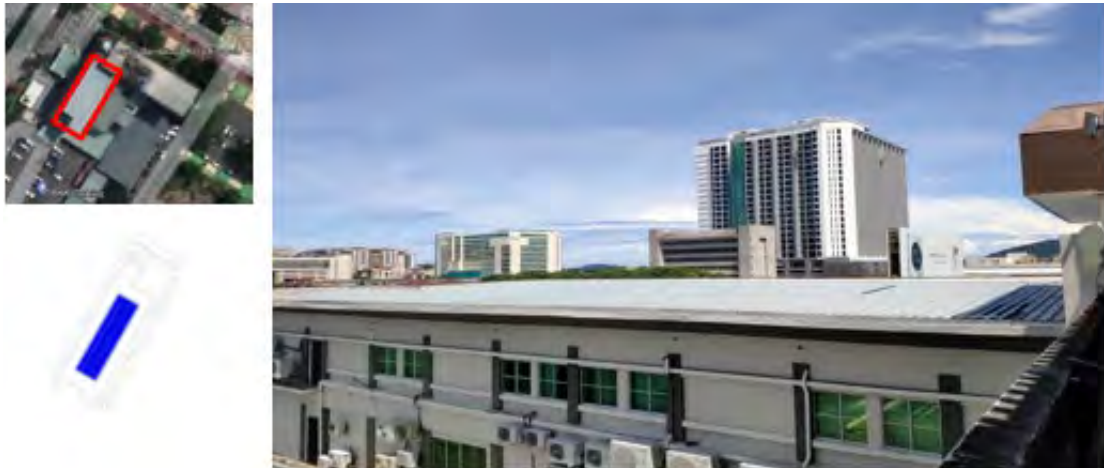
図 4-21 エリアAの屋根の様子
