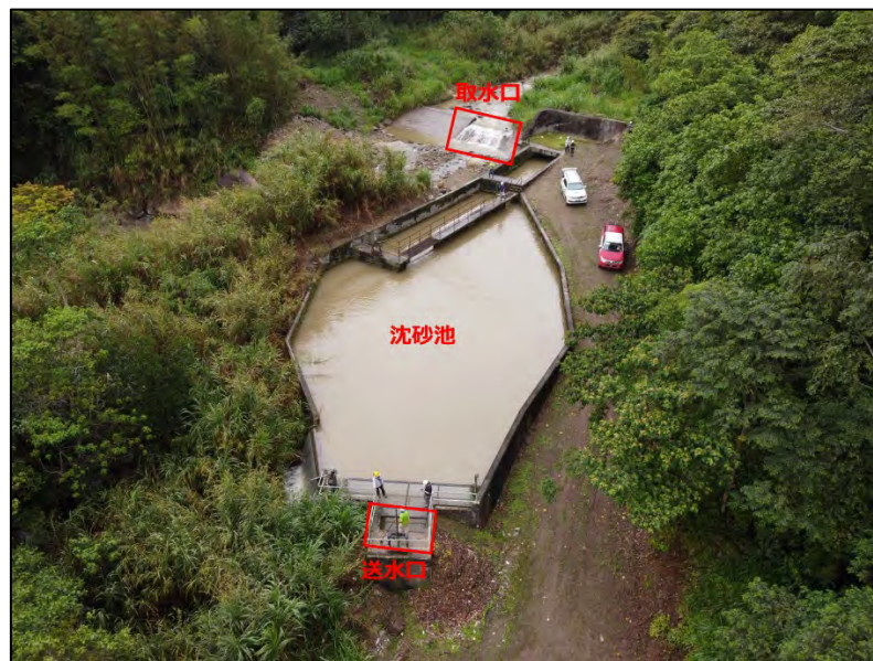
図 4-8 沈砂池の全景（令和3年度事業においてドローンで撮影した様子）
