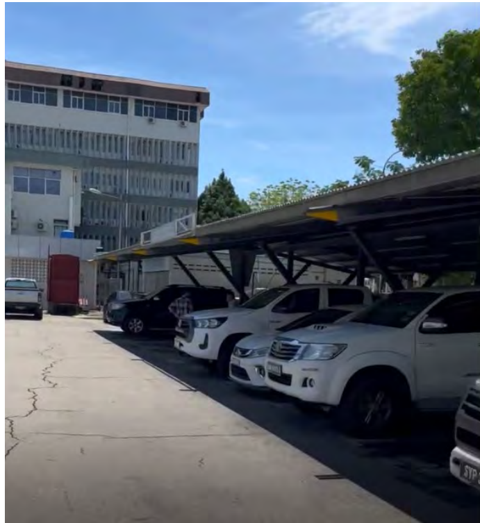
図 4-24 屋根付きの駐車場
