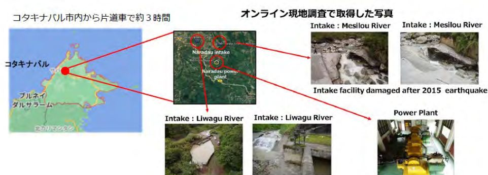
図 4-1 Naradau 発電所の位置及び概要設備
