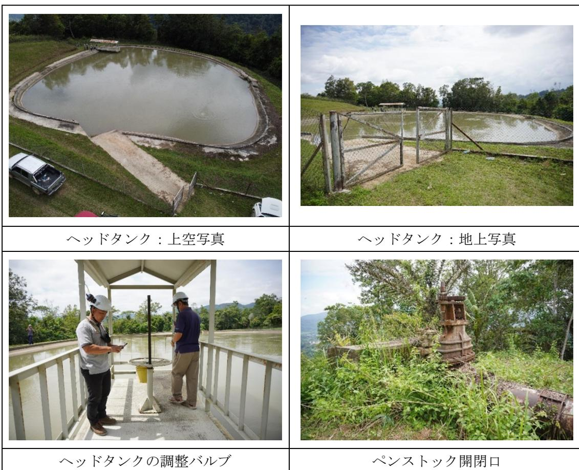
図 4-4 Carabau 発電所ヘッドタンク
