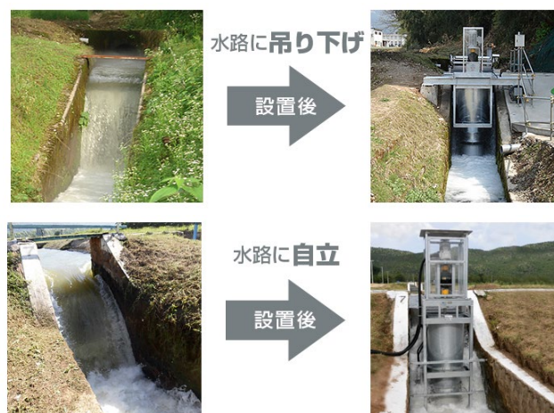
図 4-17 株式会社北陸精機のパワーアルキメデスの設置事例
