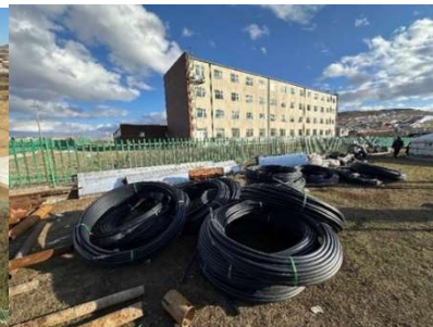
地中熱交換器 (ダブルUチューブ)
