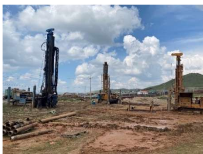
ボアホール施工
