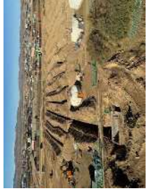
121-р сургуулийн хөл бөмбөгийн талбай дахь газрын гүний дулааны солилцуурыг суурилуулсан хэсэг
