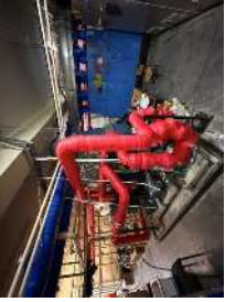
Узелийн өрөө (цэнхэр өнгийн төхөөрөмж нь Дулаан насос)
