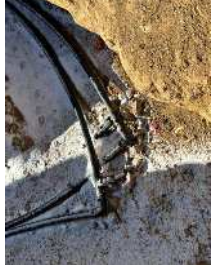
Газрын гүний дулааны босоо хоолойноос хөндлөн хэвтээ хоолойг татсан суурилуулалт XX
