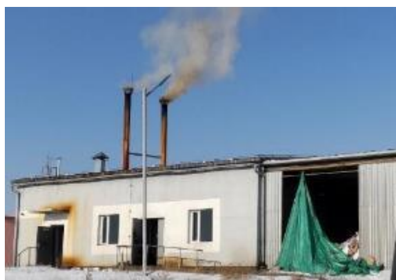
図 5-4 既存石炭焚きボイラ設置場所
