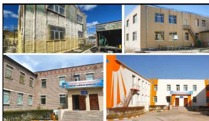
図 2-13 断熱改修された学校
