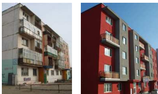
図 2-14 GIZ プロジェクト (集合住宅の改修前と改修後)
