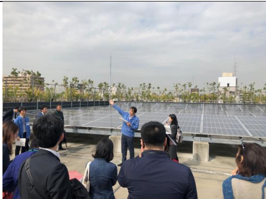
横浜市内 現地視察 (南区庁舎 (BEMS) の見学)
