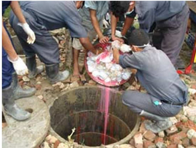
図 4-10 地中封じ込め処分の様子 1
