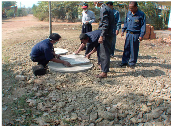
図 4-11 地中封じ込め処分の様子 2
