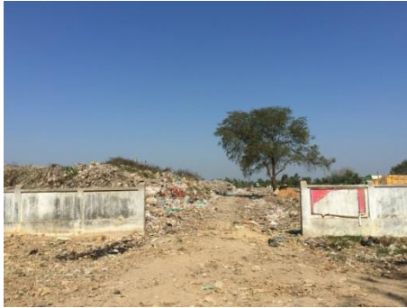
廃棄物処分場の外観
