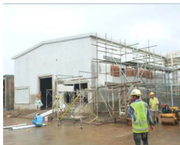
ボイラー建屋
