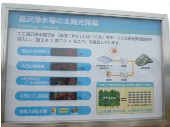
発電量モニタリングパネル
