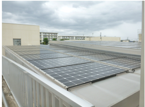
浄水場の蓋上部に設置された太陽光パネル
