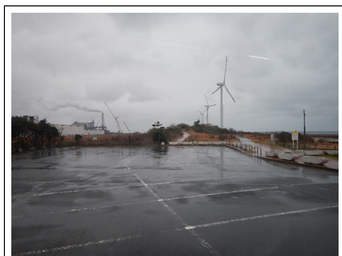
響灘臨海工業団地の沿岸部風力発電施設 (晴れの日には沖合に浮体式風車が見える)
