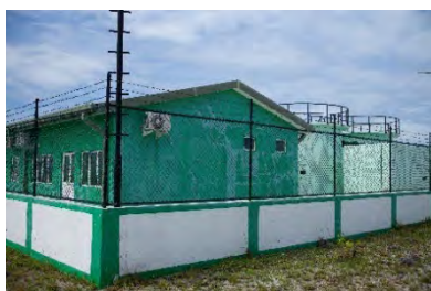
復興支援により提供された 下水処理施設
