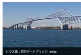
トラス橋：東京ゲートブリッジ (東京都)
