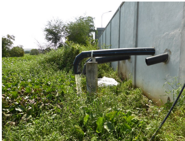
写真 4.1.1 都内ビール工場からの排水(着色排水、洗剤の泡)
