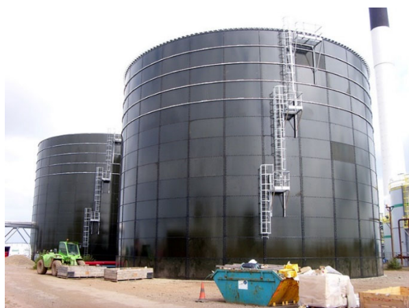
写真 4.2.1 メタン発酵槽※
