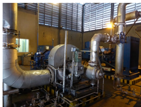
写真 3.1.5 タービン・発電機
