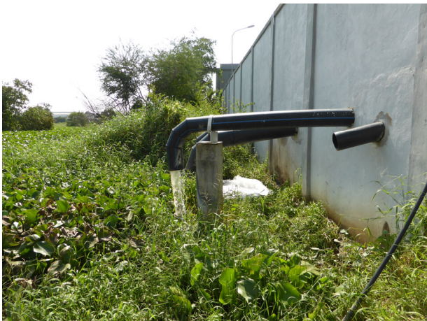
写真 1.3.3 都内ビール工場からの排水 (着色排水、洗剤の泡)
