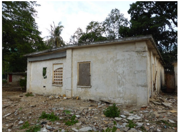
写真 1.3.4 都内病院の排水処理施設 (液体医療廃棄物を含む排水が無処理のまま放流)
