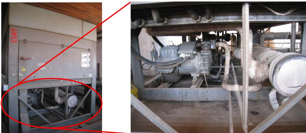
写真 2: 既設の CIAT 製チラーシステム(1997 年製)
