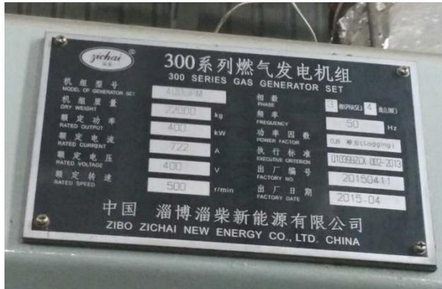
写真 ガス発電施設・銘板(400kW×2 台)
