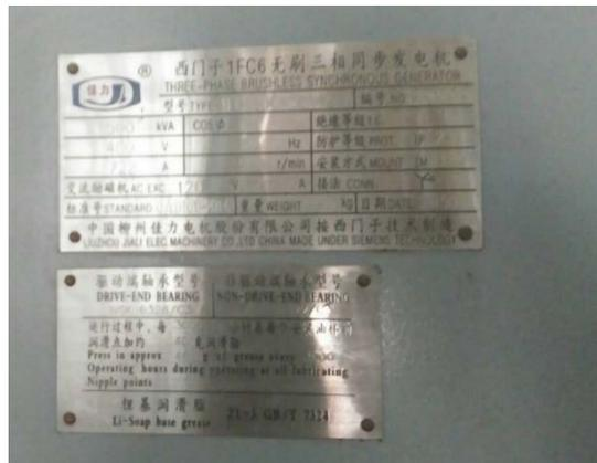
写真 ガス発電施設・銘板(500kVA×10 台)
