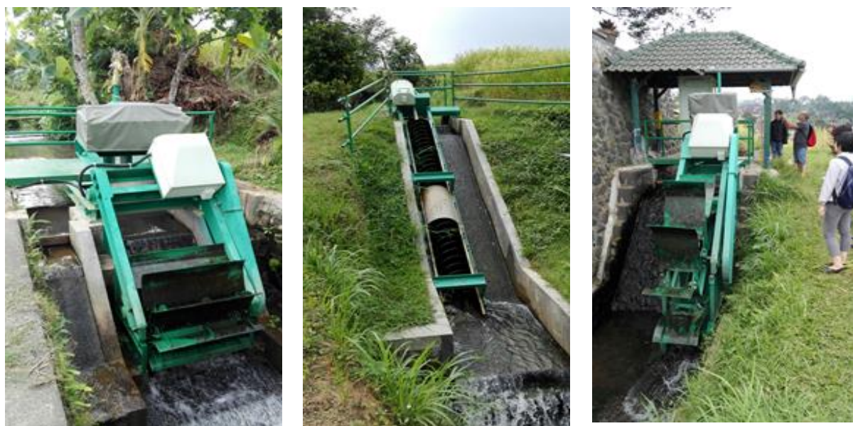
タバナン県に設置した小水力発電設備
