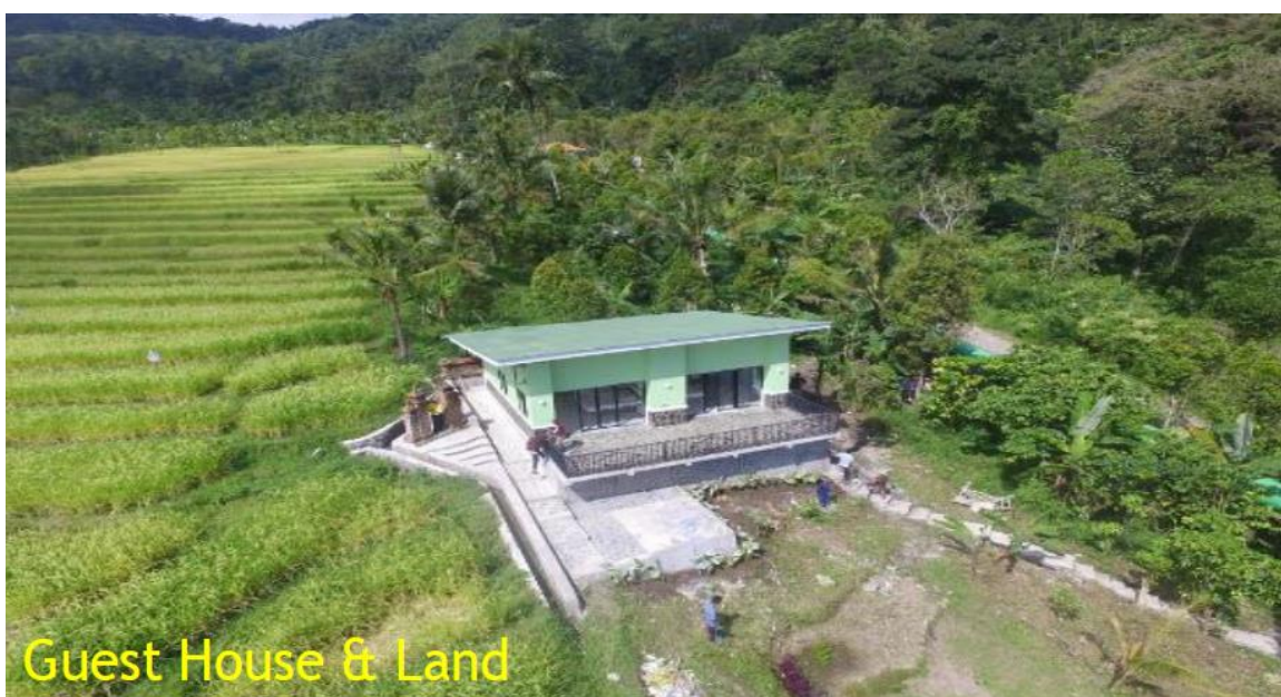
既設水力発電所周辺設備の状況（太陽光パネル設置候補地）
