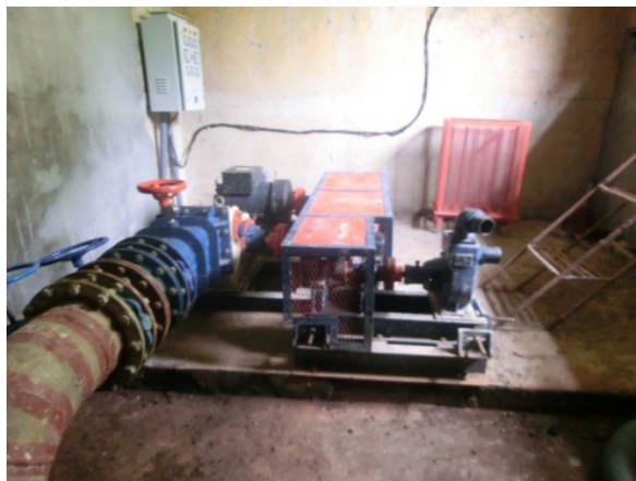
発電所建屋内の状況
