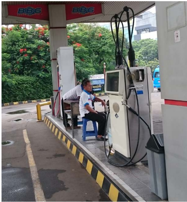
CNG 供給スタンドの様子
