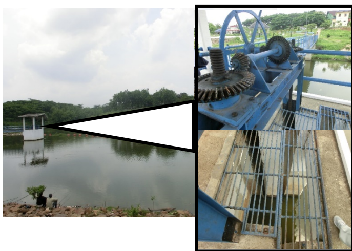
ダム湖内の取水塔の状況
