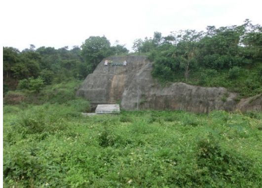
発電所周辺の状況
