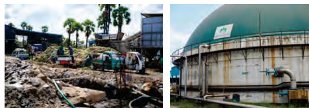
▲ Biogas Plant Mhasakthiにおける有機性廃棄物回収 トロンメルでプラスチックを分離後、メタン発酵を実施
