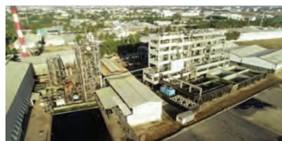
▲CETPの一つであるMurugampalayam CETPを視察 (2025年8月19日)
