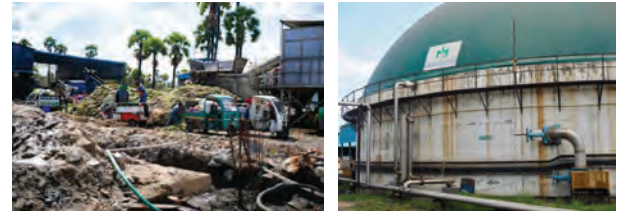
▲ Biogas Plant Mhasakthiにおける有機性廃棄物回収 トロンメルでプラスチックを分離後、メタン発酵を実施
