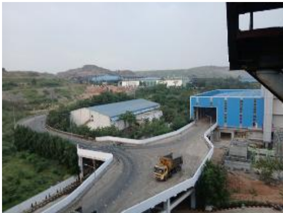
最終処分場（遠景）
