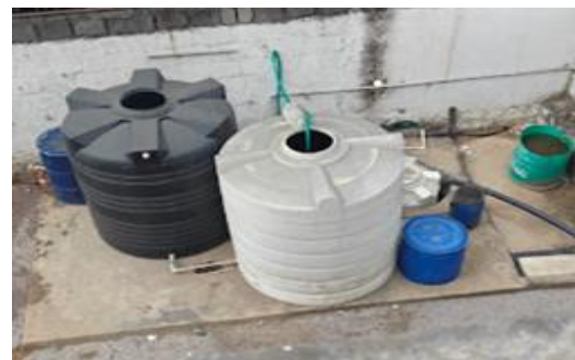
有機廃棄物（液体）を保管しているドラム缶（工場）
