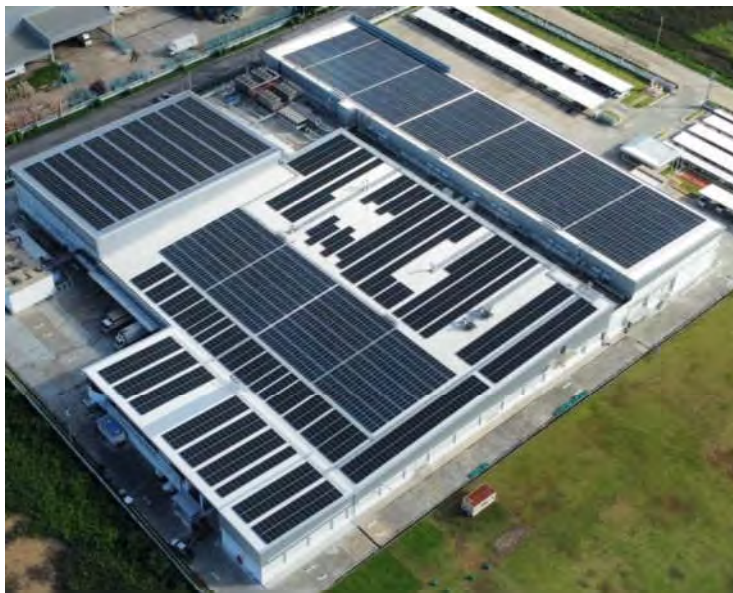
Introductory Photo - 導入写真
