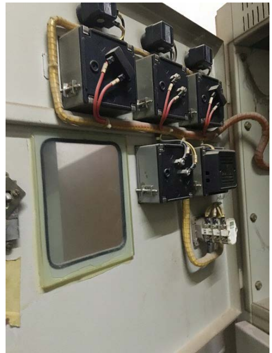
図 7.12 受電パネル内部
