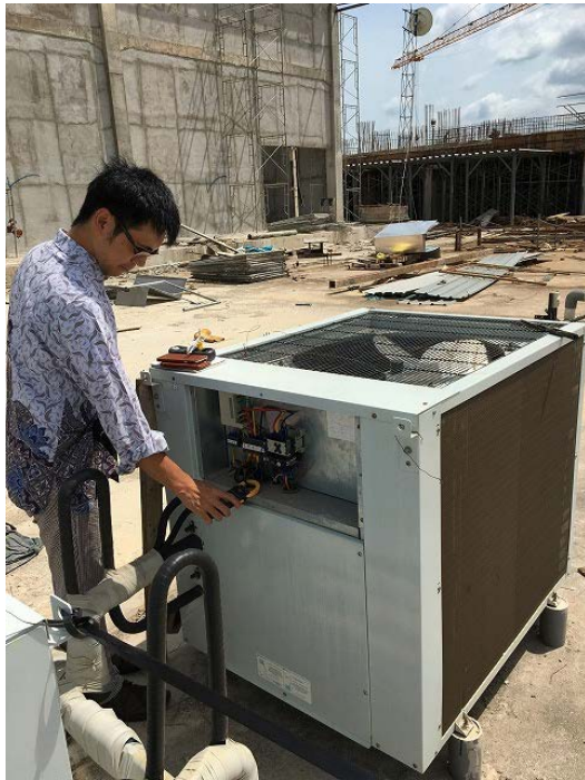
図 7.9 室外機の電圧測定
