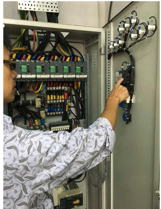
図 7.16 受電パネル内部
