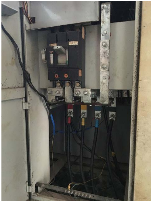
図 7.3 受電パネル内部
