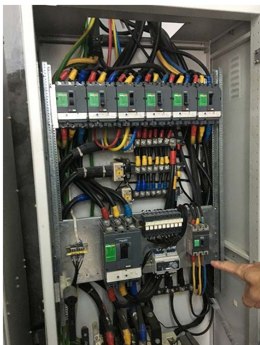
図 7.17 受電パネル内部
