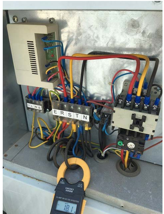
図 7.10 室外機の電圧測定
