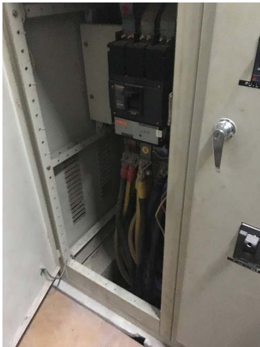
図 7.11 受電パネル内部
