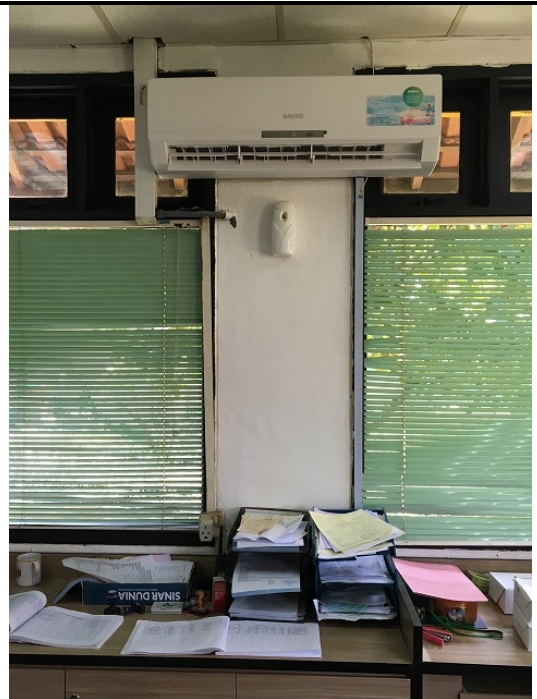
図 7.18 コントロールセンター
