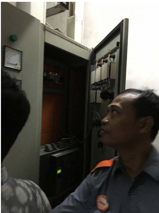
図 7.3 受電パネル内部
