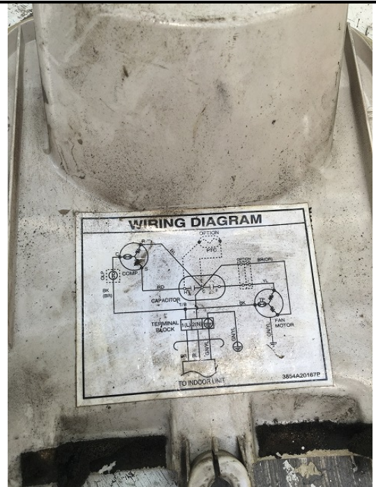
図 7.10 室外機ワイリングダイアグラム
