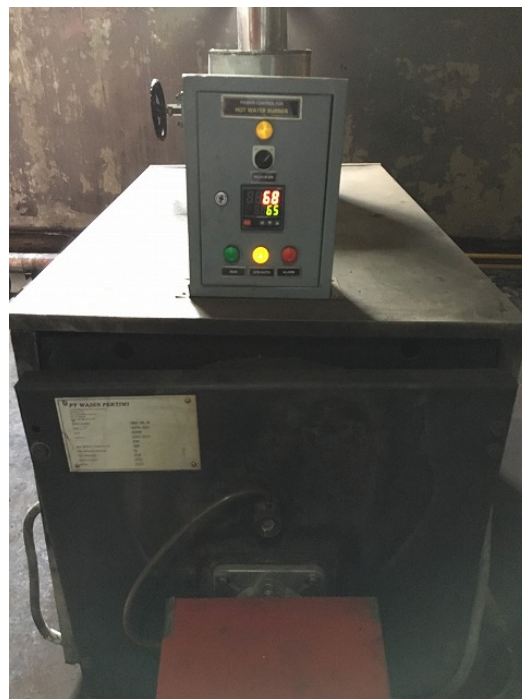
図 7.4 ボイラー制御メーター
