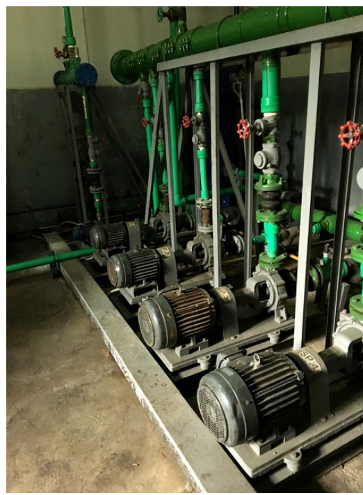
図 7.6 給湯用循環ポンプ
