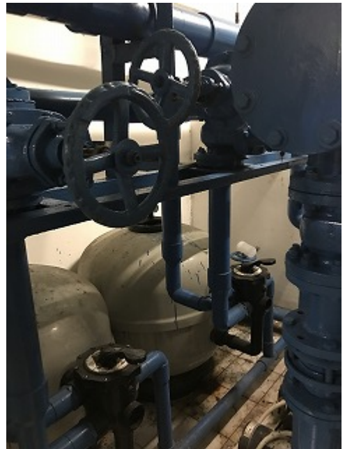
図 7.10 プール用循環ポンプ
