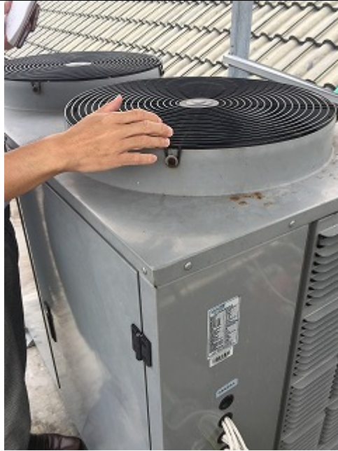
図 7.15 ヒートポンプ
