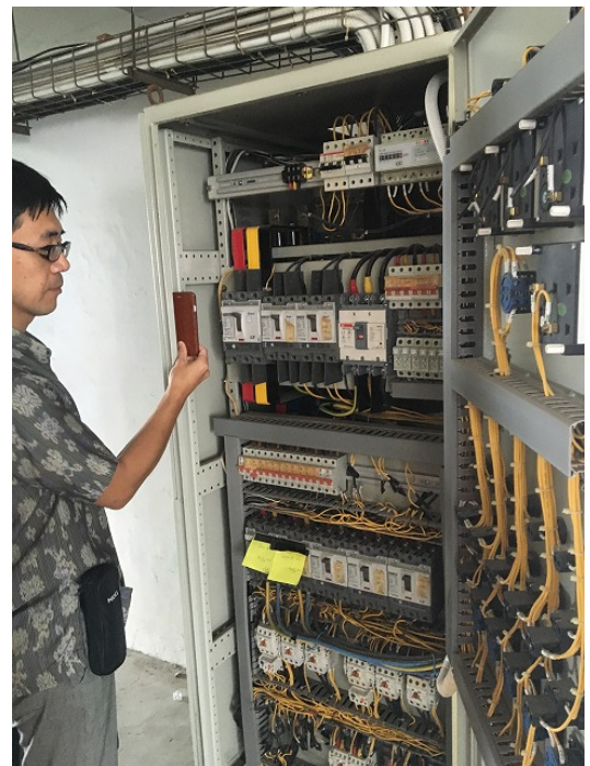
図 7.12 受電パネル内部
