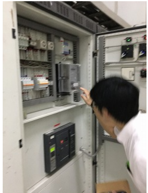
図 7.6 受電パネル内部
