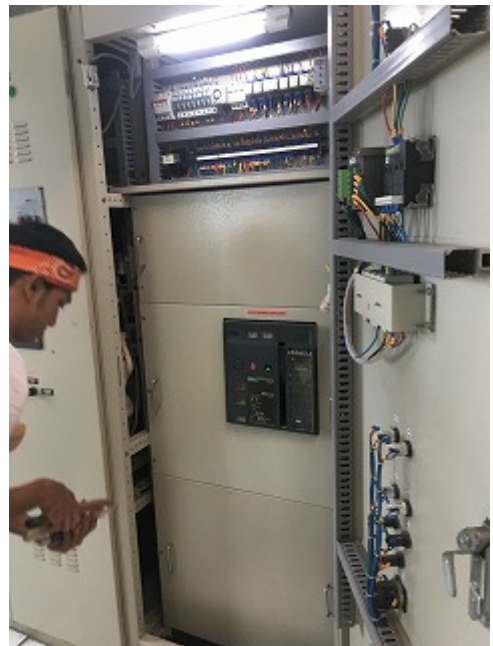
図 7.6 受電パネル内部
