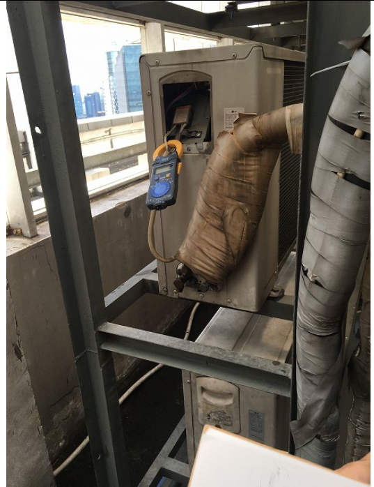
図 7.6 室外機電圧の測定
