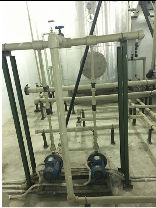
図 7.15 お湯循環ポンプ
