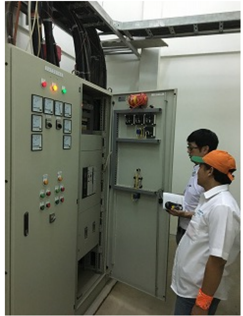
図 7.6 受電パネル内部
