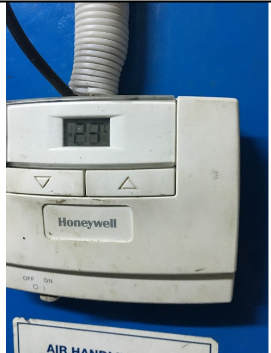
図 7.12 AHU のメーター
