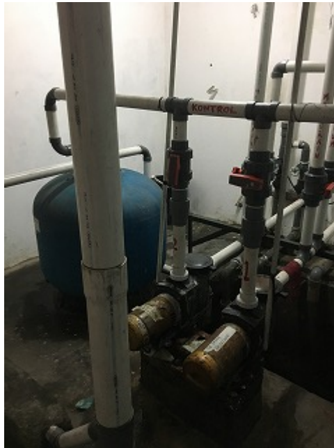
図 7.5 プール用のポンプ
