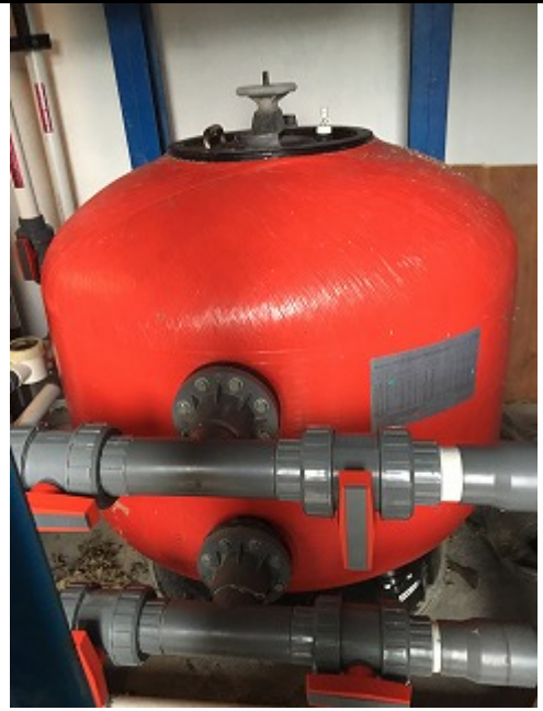
図 7.12 プール用ポンプ
