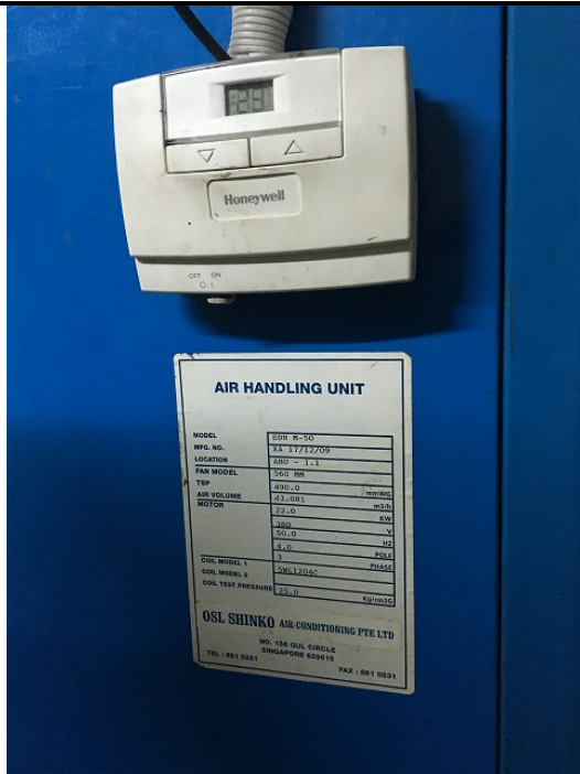
図 7.11 エアハンドリングユニット (AHU)
