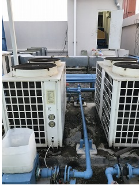
図 7.3 ヒートポンプ
