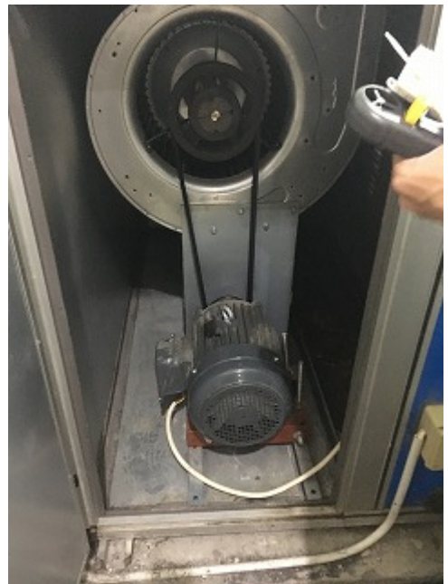
図 7.14 AHU(空調調和機)の内部
