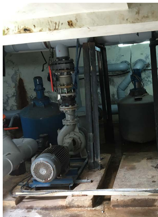
図 7.10 プール用循環ポンプ
