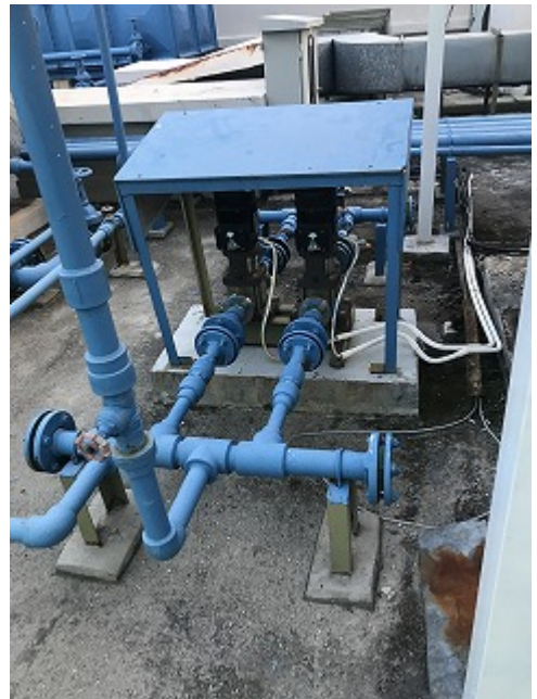
図 7.6 給湯用循環ポンプ
