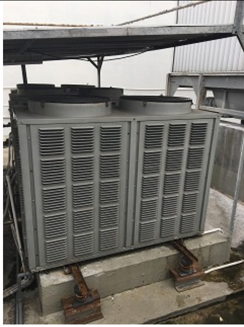
図 7.15 ヒートポンプ
