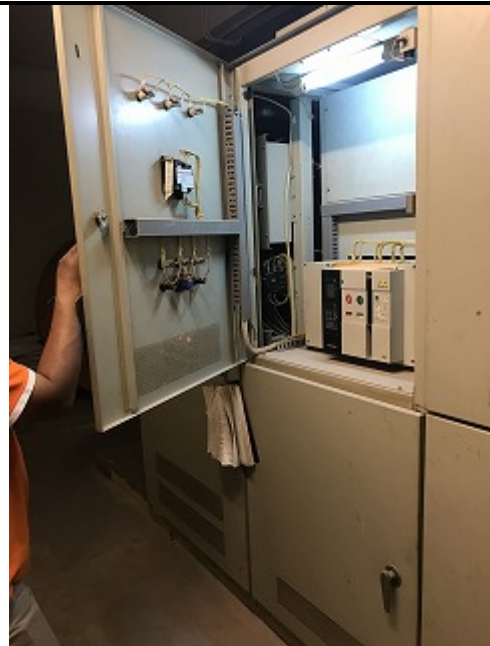
図 7.12 受電パネル内部
