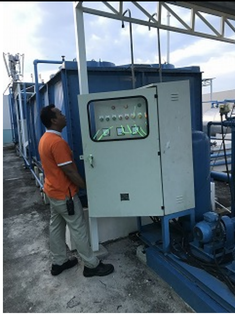
図 7.7 給湯ポンプ制御盤
