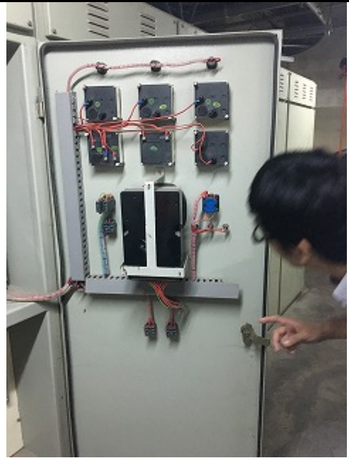
図 7.8 受電パネル内部
