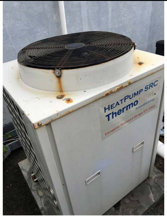
図 7.6 ヒートポンプ
