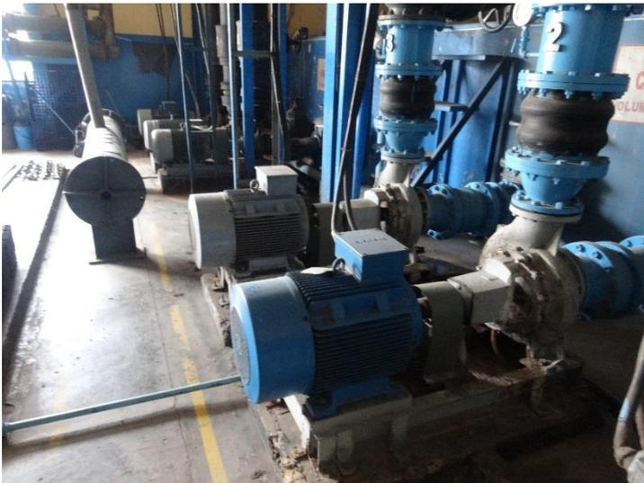
1次ポンプ方式にて熱源システムとなっており、2次側要求負荷に対して過剰に供給しており、ポンプの搬送動力を多く必要としています。
