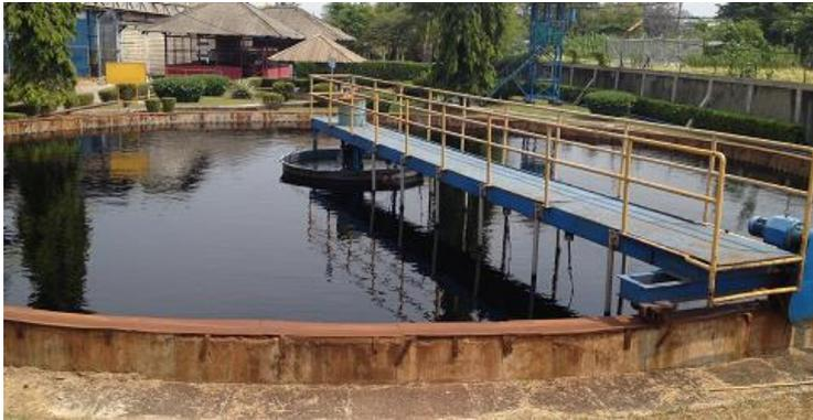
图 3-50 沈殿槽
