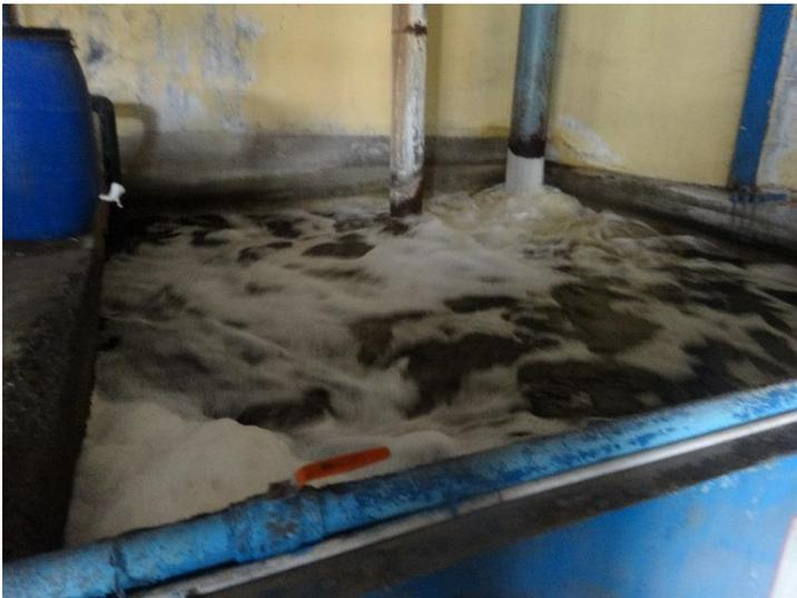
冷却水槽が設置されており、オープンシステムとなっており、水搬送動力が大幅に必要なシステムとなっている。また腐食の原因となる。その結果冷凍機にスケール等が堆積し結果的に冷凍機の効率低下になってしまう。
