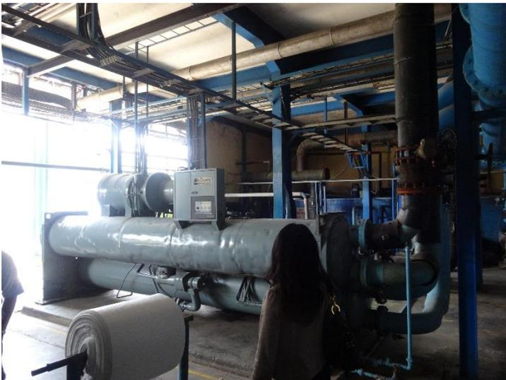
冷凍機設置後 15 年程度経過しており、2 台のターボ冷凍機があるが、1 台のみをベース運転を行っており、また稼働時間が 24 時間と長いため、かなり効率低下が想定される。
