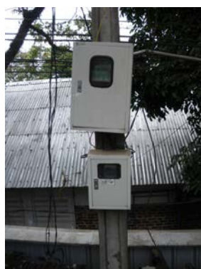
写真 1 SmartBox(上) 受電 Box(下)
