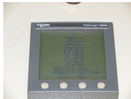
写真 41 水冷チラー用マルチメーター
