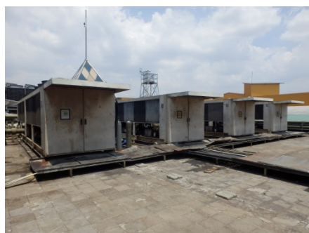
写真 42 空冷チラー (モール 1 系)
