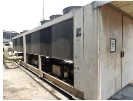
写真 2 空冷チラー (モール 1 系)
