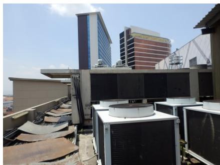
写真 44 空冷チラー（モール 2 系）
