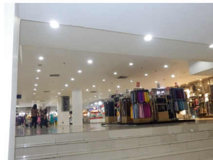
写真 22 店内通路照明 (コンパクト蛍光灯タイプ)
