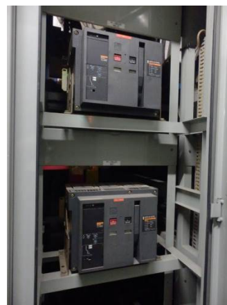
写真 36 チラー2C 系統用 ブレーカ (上)
