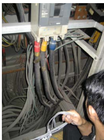
写真 7 盤下配線作業
