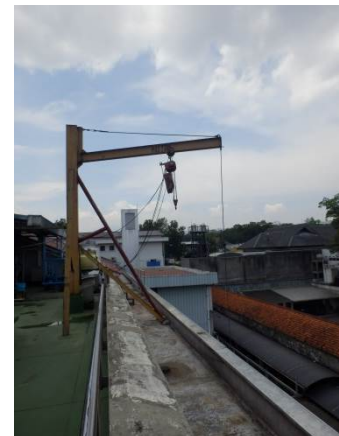
写真 54 機器吊込み用クレーン
