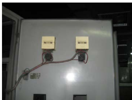
写真 5 CT 設置前 (照明)
