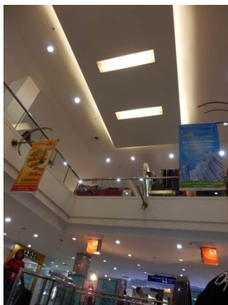
写真 21 店内通路照明 (吹き抜け部分)
