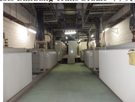
写真 33 モール施設の変圧器
