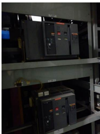
写真 35 チラー1C 系統用 ブレーカ (上)
