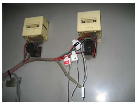
写真 6 CT 設置後 (照明)
