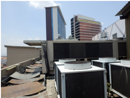
写真 3 空冷チラー (モール 2 系)
