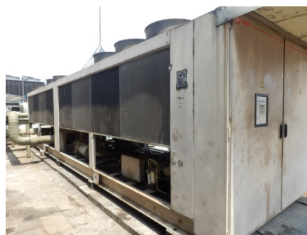
写真 43 空冷チラー (モール 1 系)
