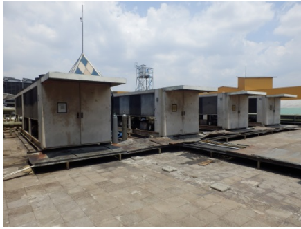
写真 1 空冷チラー (モール 1 系)
