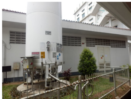
写真 49 33号建物用変電室外観
