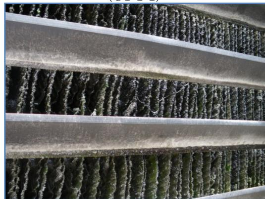
冷却塔充填材外観
