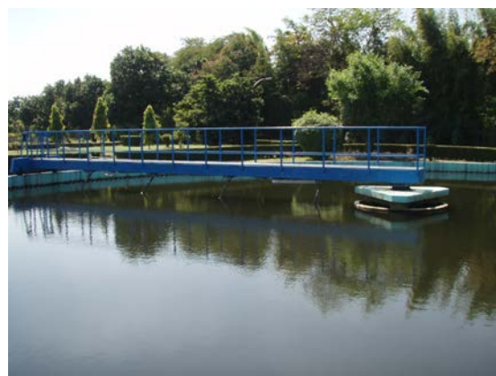
写真 4.1 (13) 廃水処理施設の沈殿池
