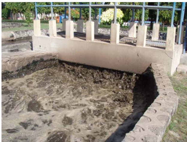
写真 4.1 (21) Keputih 汚泥処理場
