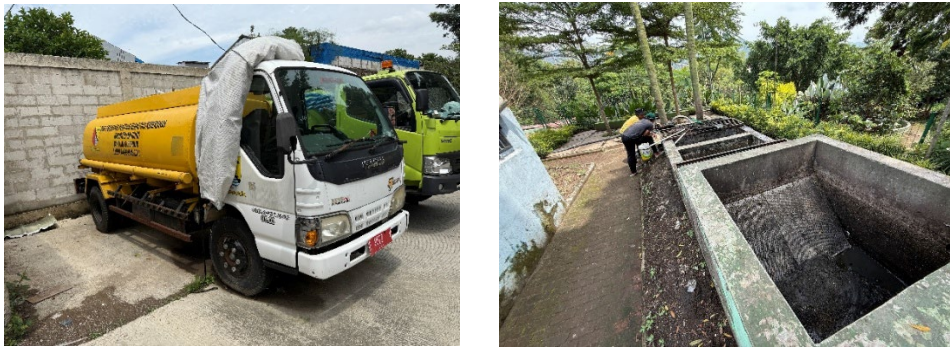
図 5-7 ブラックウォーターの収集車と回収タンク
